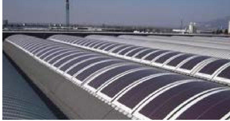
Flexibele lichtgewicht Zon-PV folie van HyET Solar op een gekromd dak.
