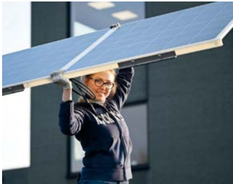
Installatie van Solarge licht-gewicht zonnepanelen voor dak- en gevelintegratie
